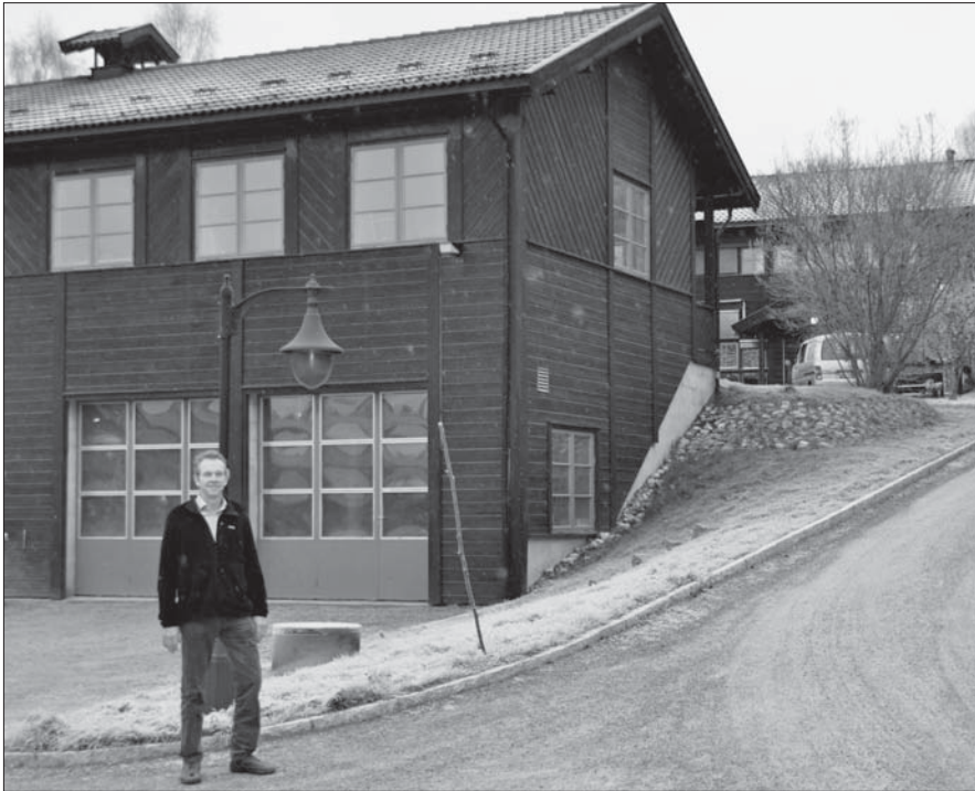
Sauherad Samtun er en betydelig arbeidsplass.
